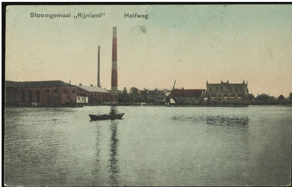
Ansichtkaart van het stoomgemaal met de in 1911 gebouwde stenen schoorsteen. Erachter de ijzeren pijp die daarvoor als schoorsteen diende (archief Rijnland).
