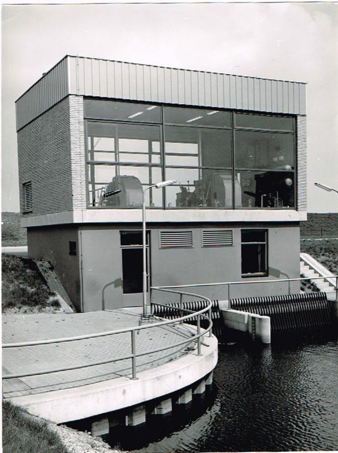
Gemaal vanaf de aanstroomzijde gezien
