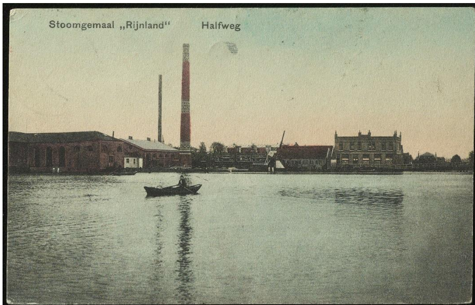
Ansichtkaart van het stoomgemaal met de in 1911 gebouwde stenen schoorsteen. Erachter de ijzeren pijp die daarvóór als schoorsteen diende (archief Rijnland).
