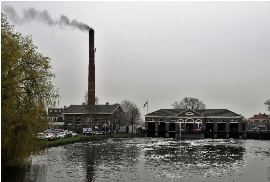
Voorzijde van Stoomgemaal Halfweg (Stoomgemaal Halfweg).
